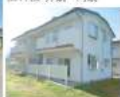
旧A棟 外観・内観
